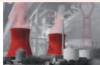
Geração de energia
