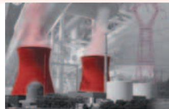
Geração de energia
